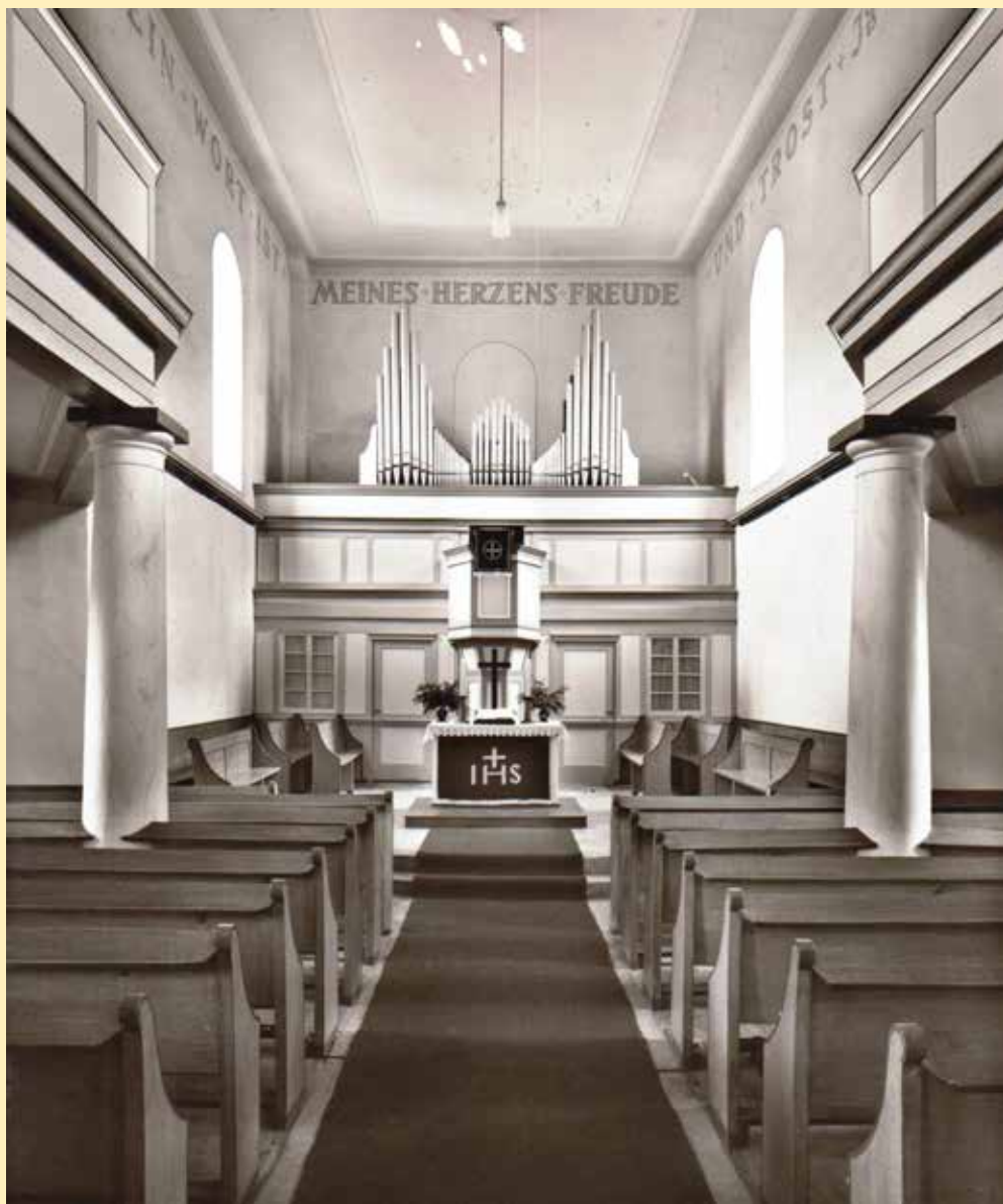
Der Innenraum von St. Peter mit Orgelprospekt nach der Renovierung von 1953
